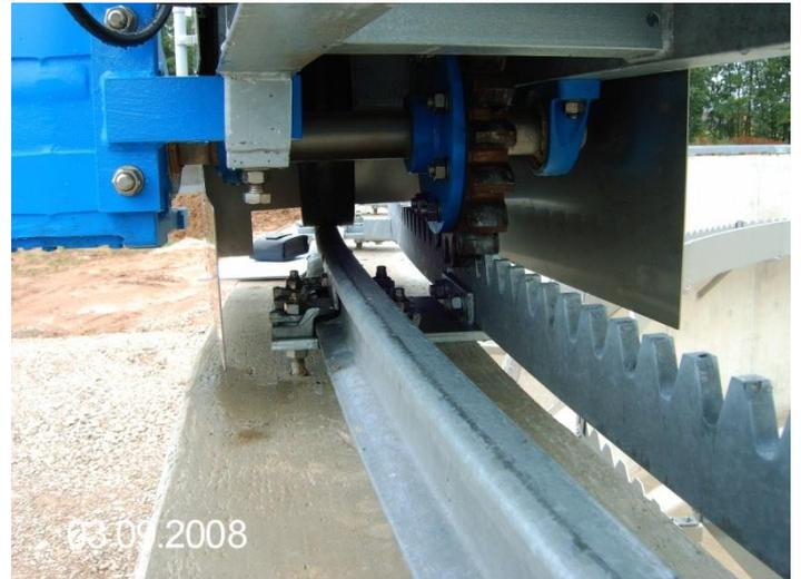
Zwangsantrieb für Längs- oder Rundräumer zur Befestigung auf der Betonkrone des Beckens. Bestehend aus einem Befestigungssystem, geraden/ gebogenen Schienen S14 / S20 und Zahnstangen. Inkl. Schienenräder und Zahnrad für Fahrträger.
